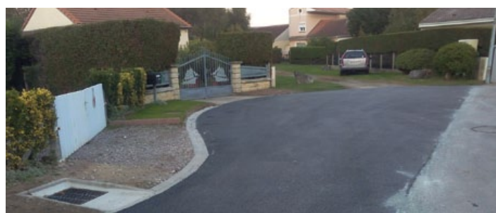
Travaux d'entretien de voirie et de récupération des eaux pluviales en divers points...
