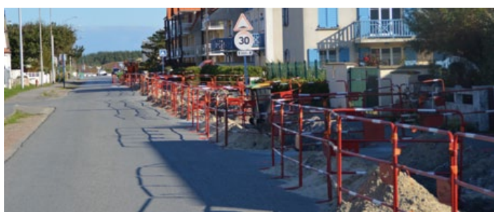
Renouvellement des lignes de moyenne tension par ERDF, rue de Cambrai.
